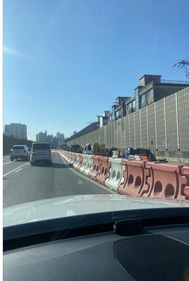
5년간 진행되는 도로 확장 공사
